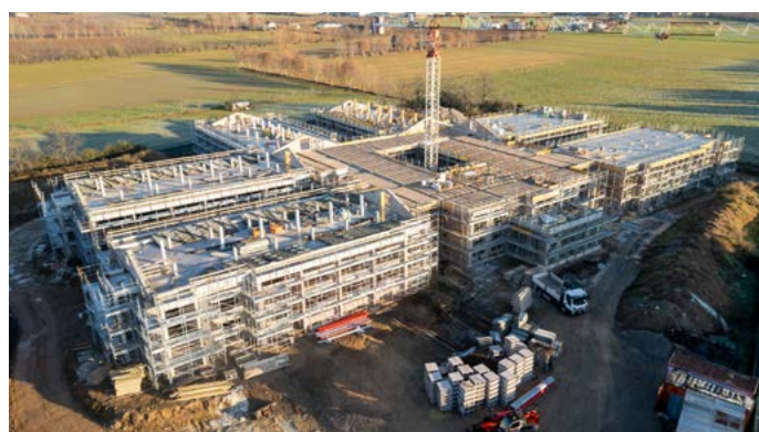
Residenza Sanitaria Assistenziale (RSA) con 120 camere - Zanica (BG)
