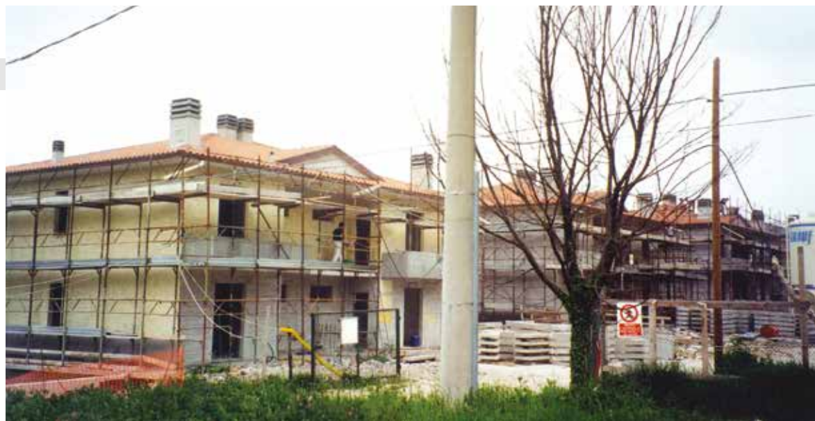
Intervento residenziale a GUALDO TADINO (PG) - 1995
