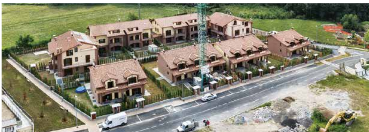
Complesso residenziale a DOLZAGO (LC) - 2009
