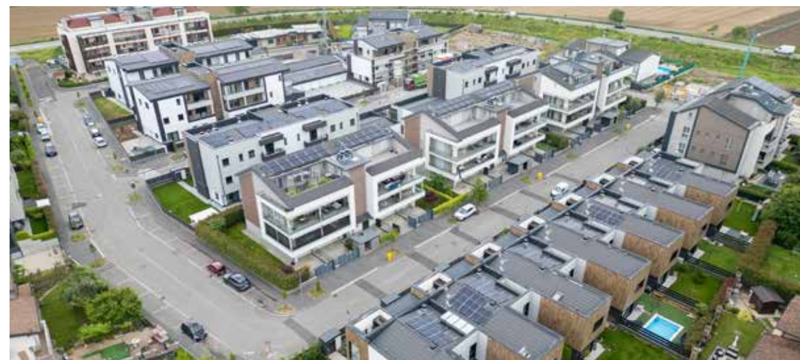
Palazzina 38 alloggi Buccinasco (MI) - 2024
