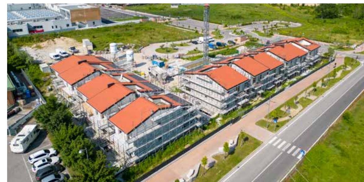
Intervento di case a Schiera 25 alloggi a Peschiera (VR) - 2022
