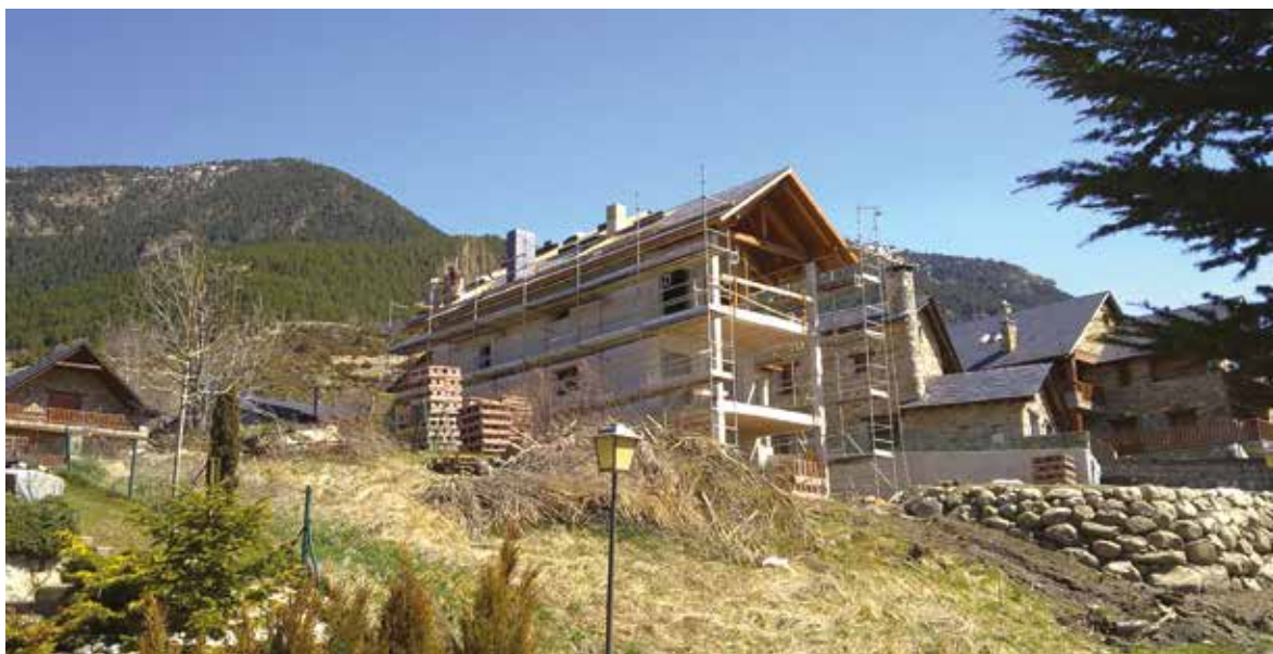
Edificio plurifamiliare realizzato a CERIER HUESCA - (SPAGNA) - 2011
