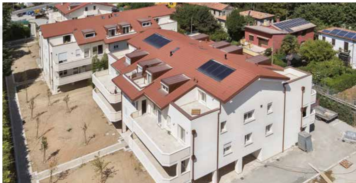
Intervento di 2 palazzine a PADOVA - 2011
