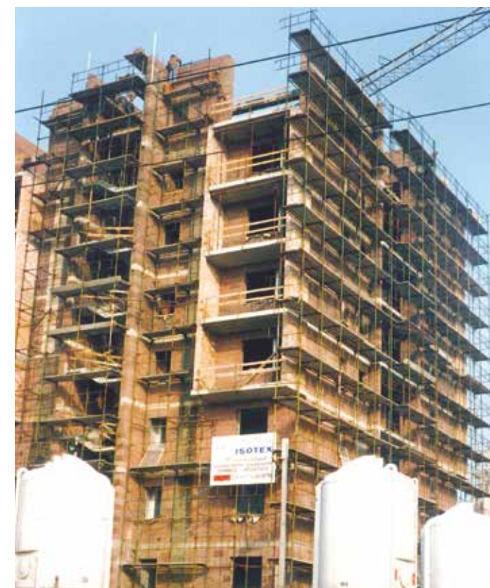
Edificio 8 piani con 28 alloggi a PARMA - 1991
