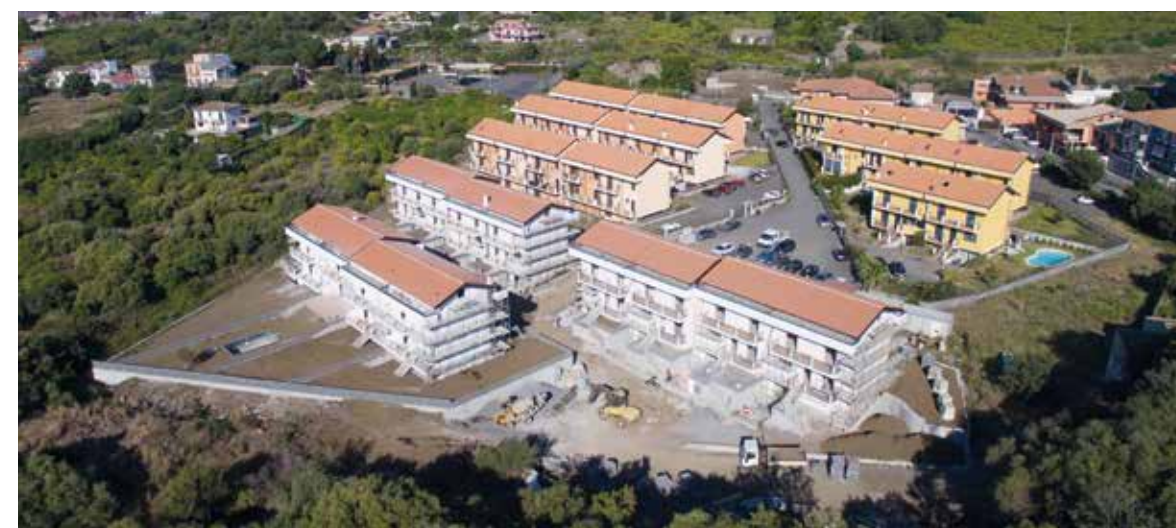
Quartiere residenziale ad ACIREALE (CT) - 2017
