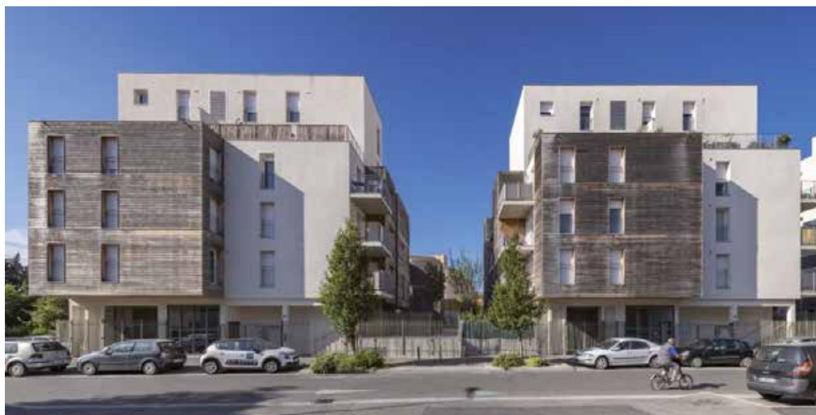
Quartiere residenziale realizzato ad AVIGNONE - (FRANCIA) - 2014-2015
