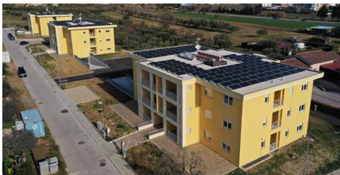
Intervento di 3 palazzine a MOSCIANO SANT'ANGELO (TE) - 2019
