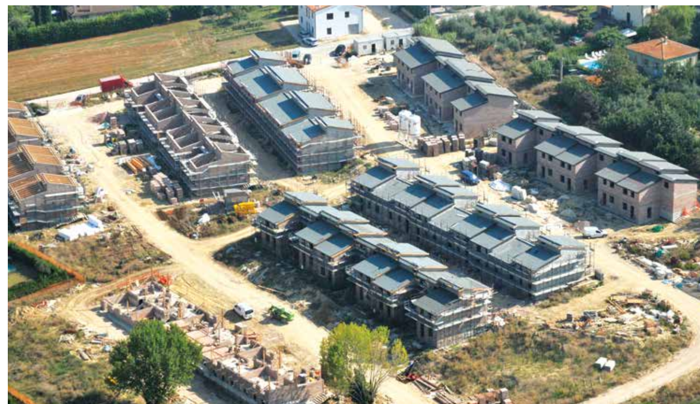
Intervento di 46 alloggi a SANT'ENEA - 2009
