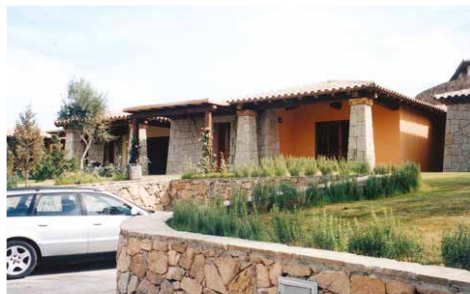
Intervento residenziale a CAPO CODA CAVALLO (NU) - 1999
