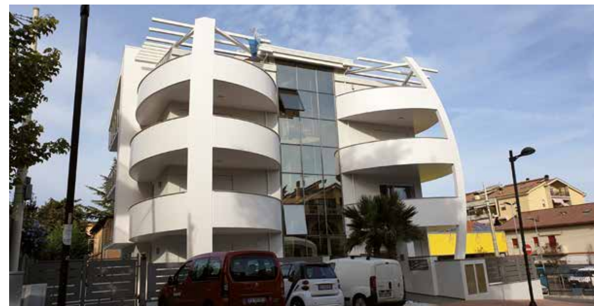
Edificio residenziale a PESCARA - 2016
