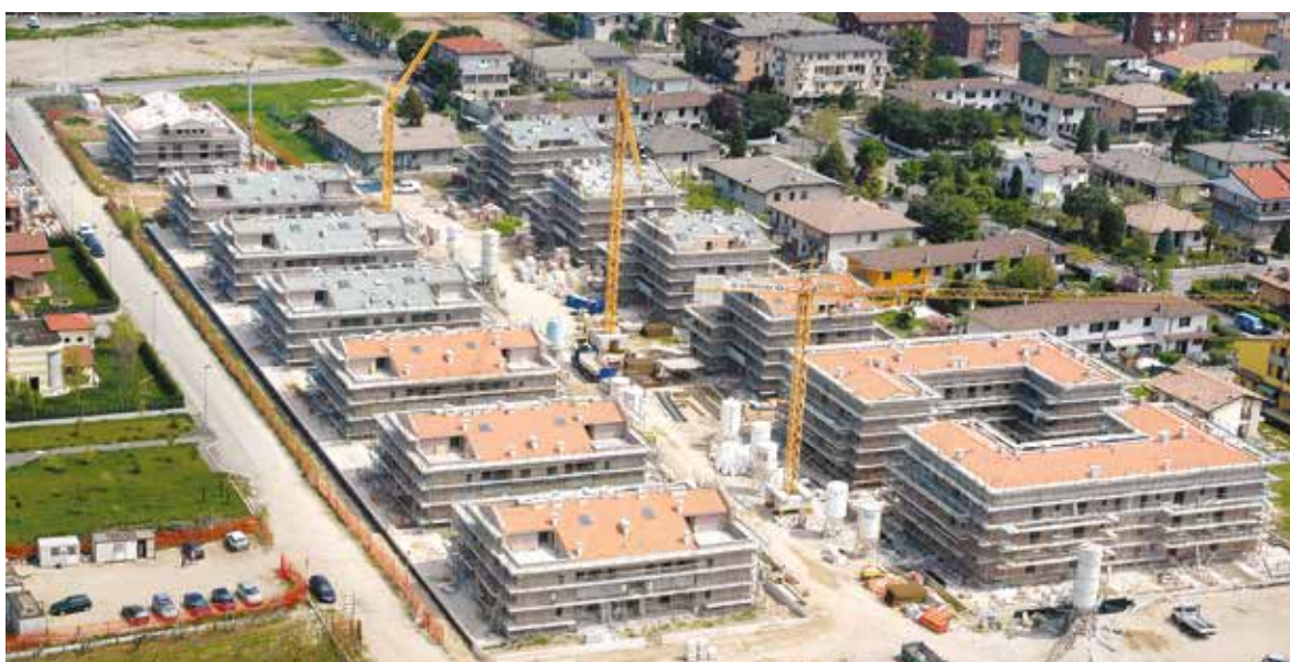
Quartiere residenziale di 162 alloggi a VERONA - 2005
