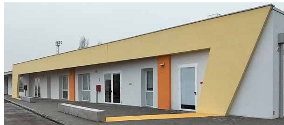
Edificio scolastico a SAN PROSPERO (MO) - 2019
