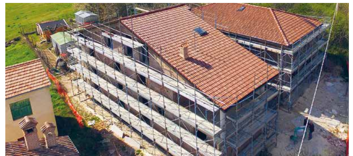
Intervento di 2 palazzine a SCOPPITO (AQ) - 2017
