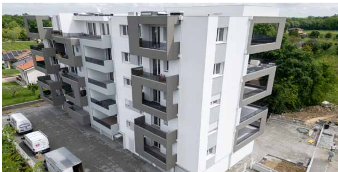
Palazzina 6 piani Residence Pegaso a Favaro Veneto - 2024
