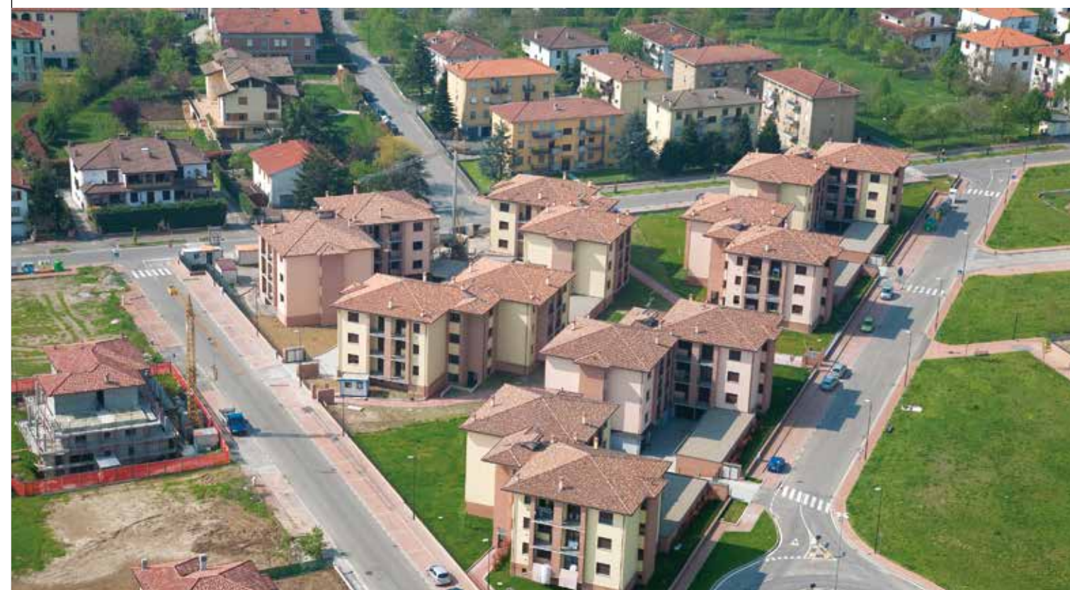
Quartiere residenziale di 7 palazzine a NOCETO (PR) - 2006
