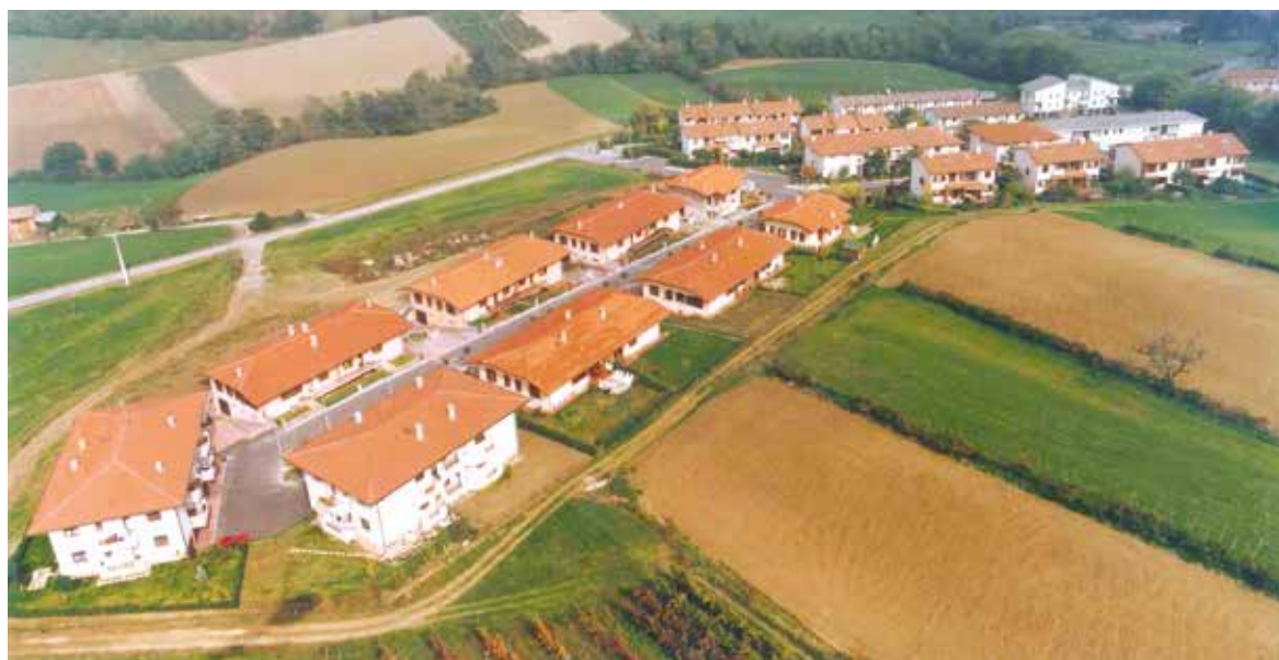
Intervento di 80 alloggi a SALSOMAGGIORE (PR) - 1986
