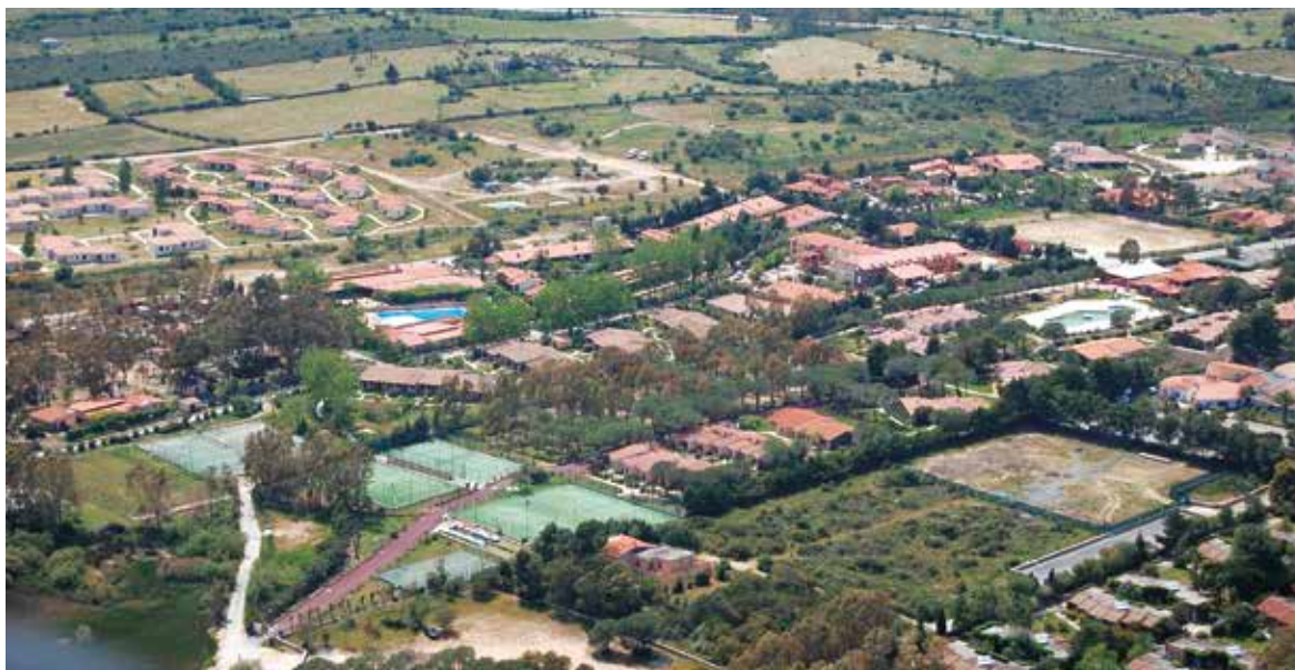
Intervento alberghiero di 120 camere a BUDONI (NU) - 2004
