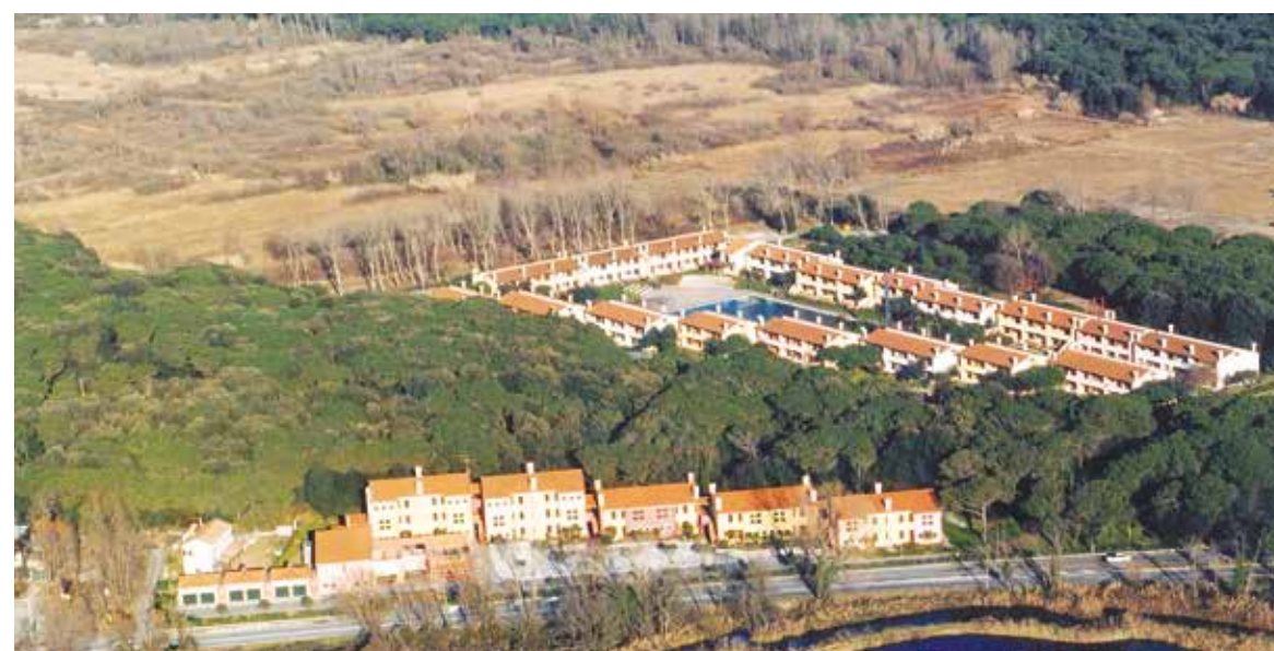
Intervento di 60 alloggi a ROSOLINA (RO) - 1999
