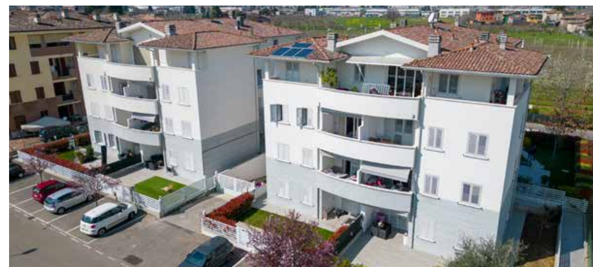
Intervento 2 palazzine a Vignola (MO) - 2022
