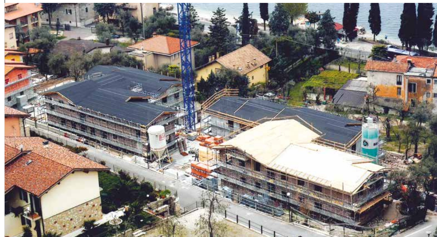
Intervento di 40 alloggi a GARDA (VR) - 2005
