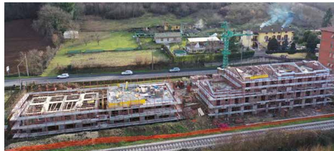
Intervento di 2 palazzine 16 alloggi a RIETI - 2020
