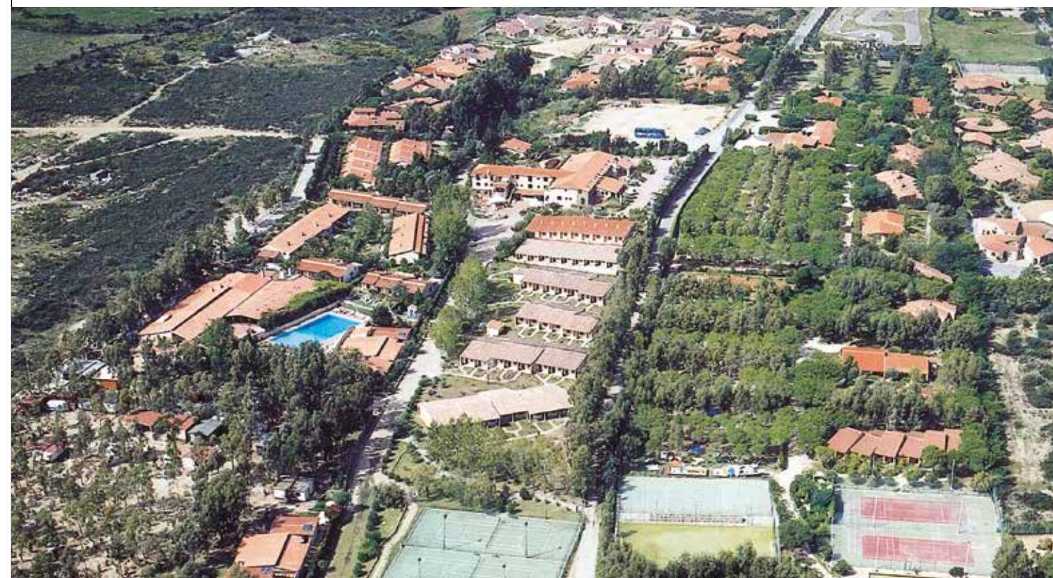
Intervento a SAN TEODORO (NU) - 2000
