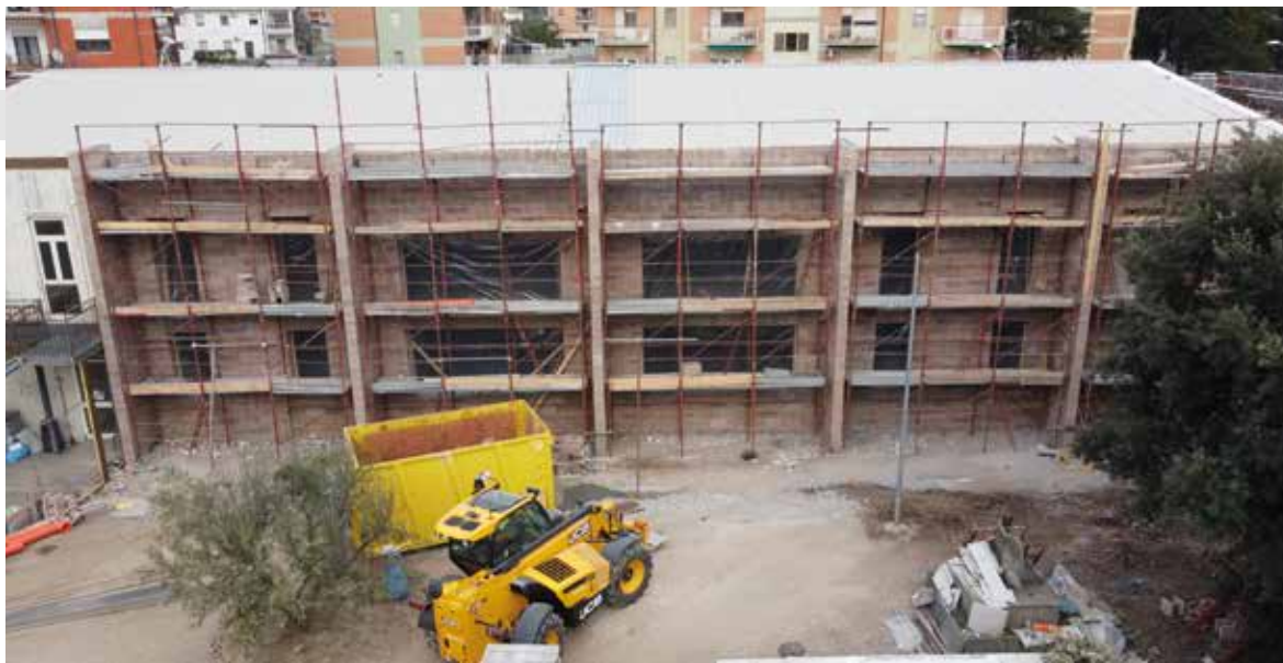
Scuola superiore "F. Orioli" (VT), Realizzata con esoscheletro
