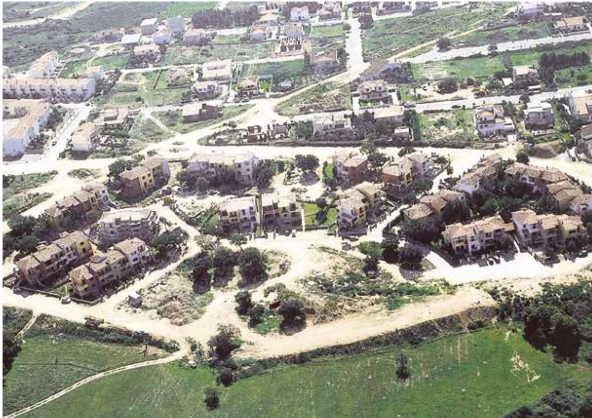
Complesso residenziale di 96 alloggi a NUORO - 2001
