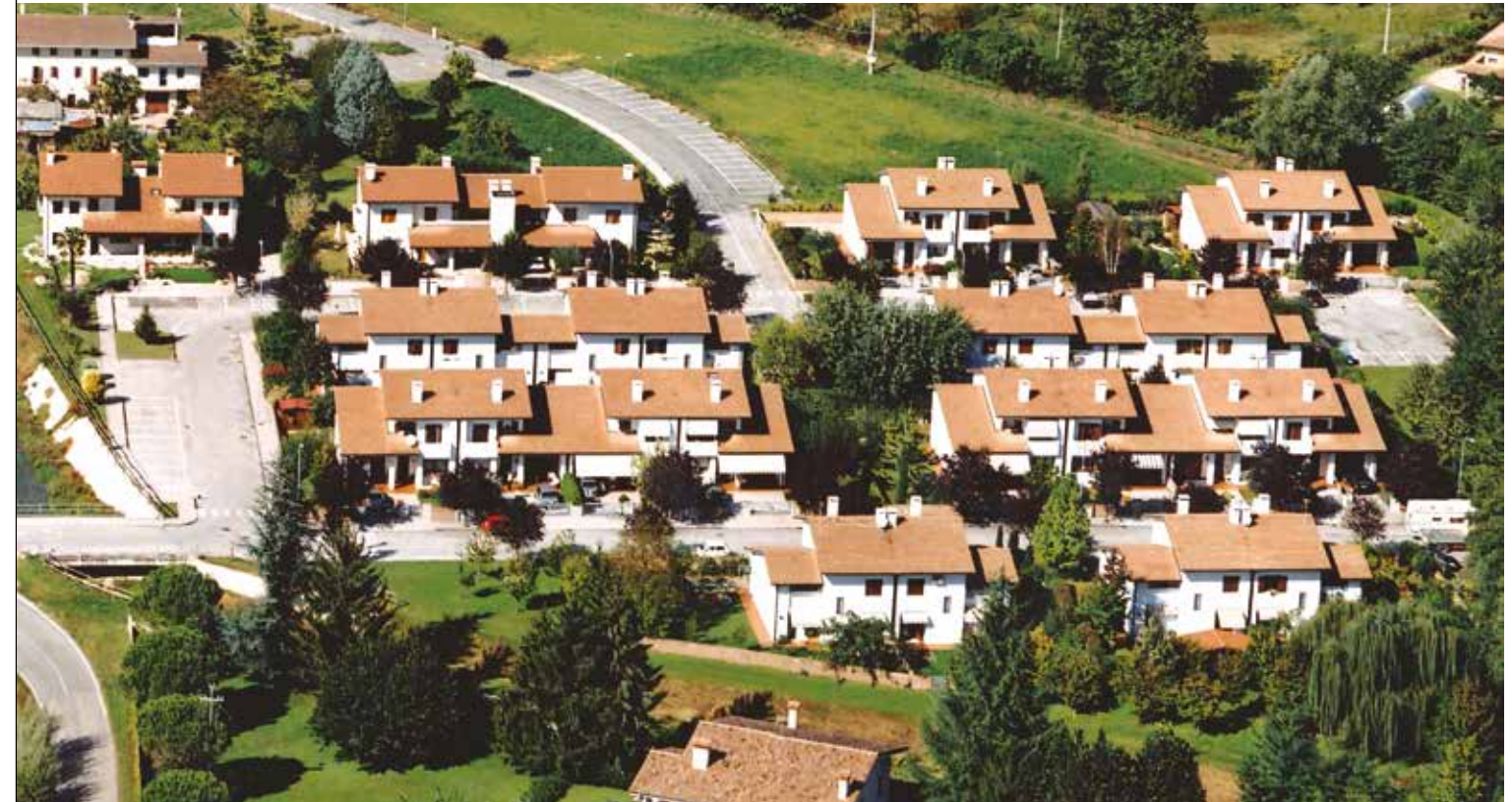
Complesso residenziale di 54 villette a MUSSOLENTE (VI) - 2001
