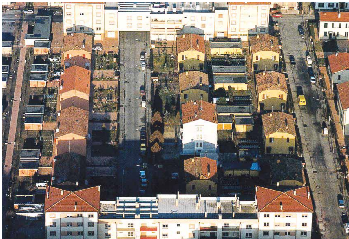
Realizzazione di condomini a FERRARA - 1999
