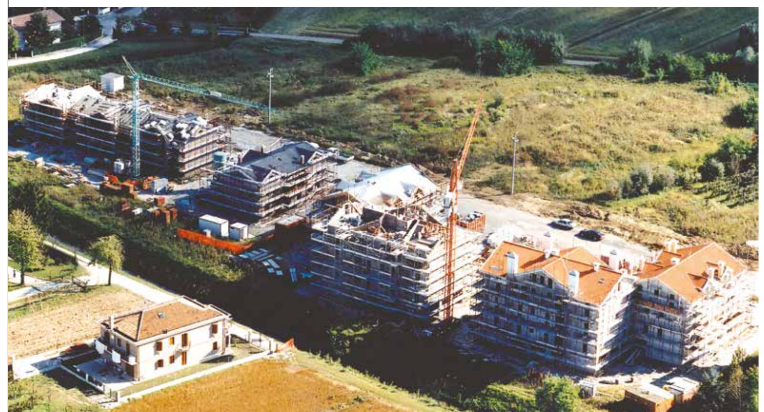
Quartiere residenziale di 160 alloggi a VENEZIA - 2002
