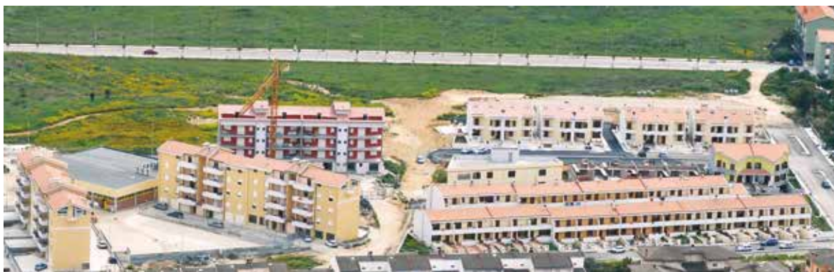
Intervento di 200 alloggi PORTO TORRES (SS) - 2004-2007
