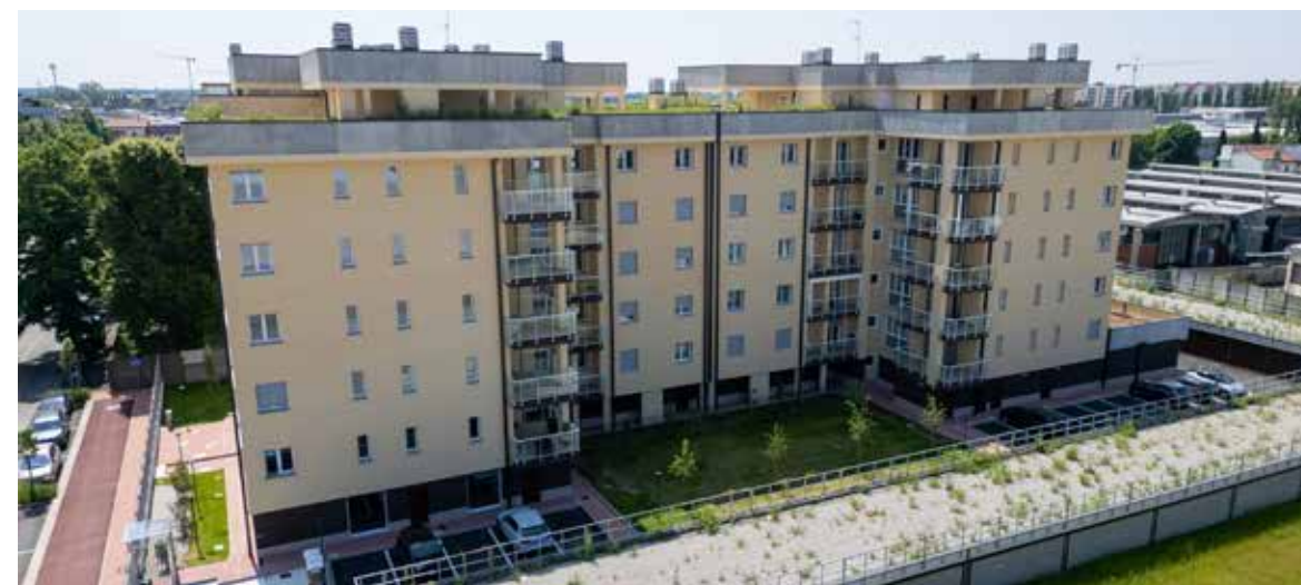
Palazzina 38 alloggi Buccinasco (MI) - 2024
