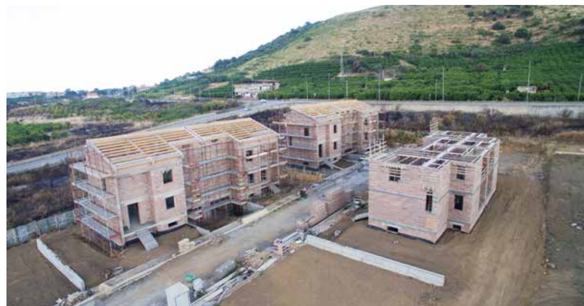
Intervento di 3 palazzine a PALAGONIA (CT) - 2017
