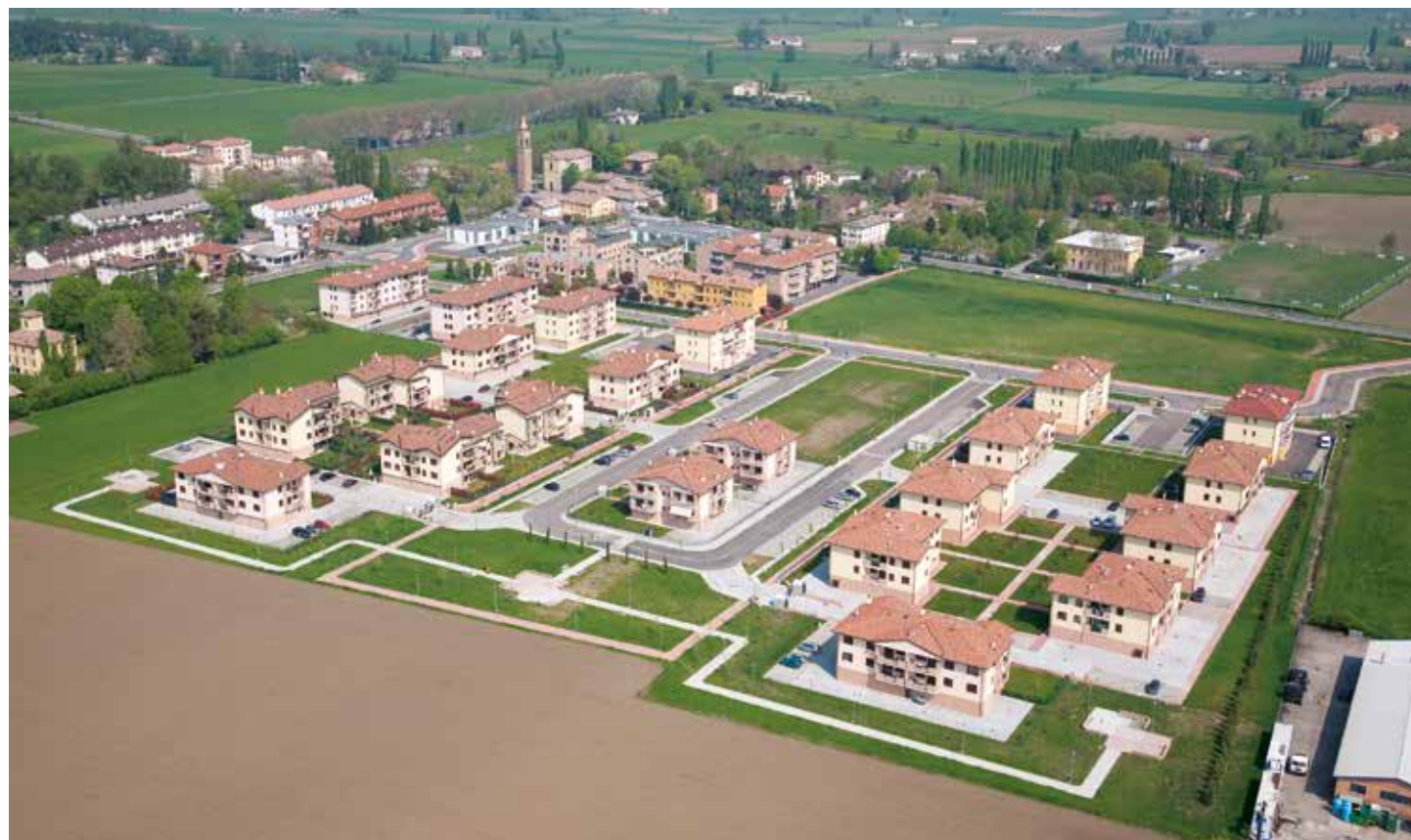
Realizzazione di 23 palazzine a SAN PROSPERO (PR) - 2007
