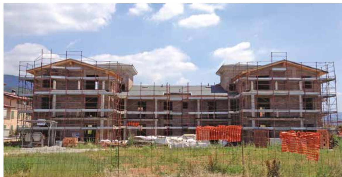
Intervento di 17 alloggi a RODENGO SAIANO (BS) - 2012
