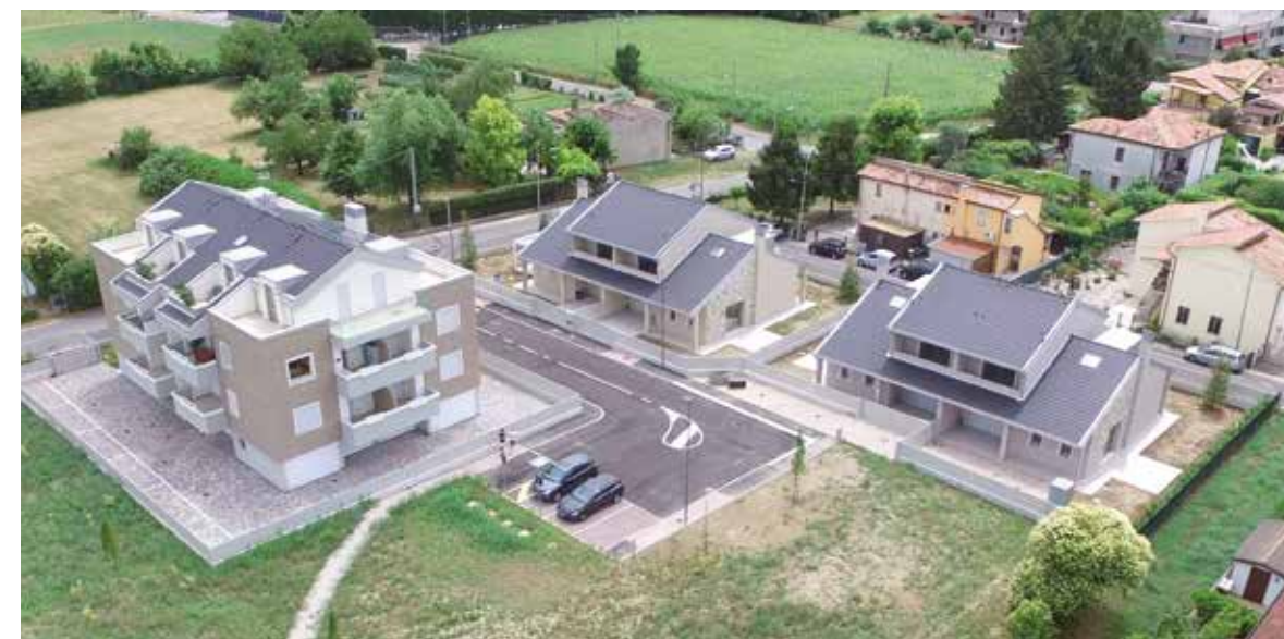
Quartiere Residenziale 14 alloggi a PADOVA - 2016
