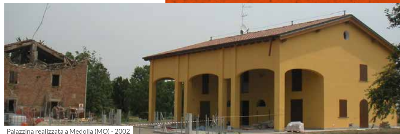
Palazzina realizzata a Medolla (MO) - 2002
