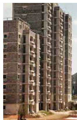
Edificio a Norimberga (Germania)
