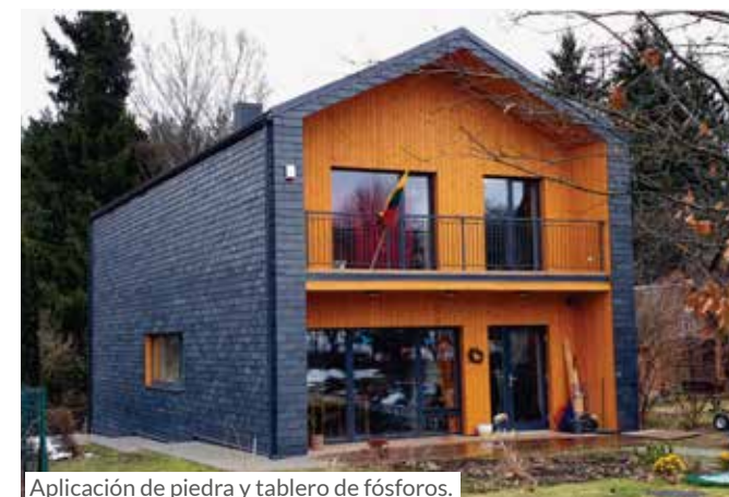
Aplicación de piedra y tablero de fósforos.
