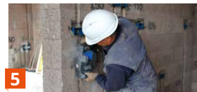
5 Realización de las canales para instalaciones
