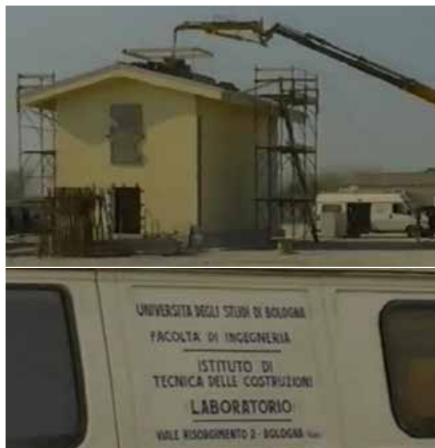
Edificio construido con bloques y forjados Isotex, probado con Vibrodina por la Universidad de Bolonia
