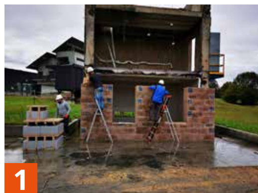
1 Se construyó un muro de 5,5x7 metros con bloque de grafito Basf Neopor® 44/23
