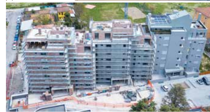
Varios pasos de procesamiento para revestimientos de gres porcelánico
