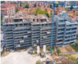
Edificio de 7 plantas en Bolonia
