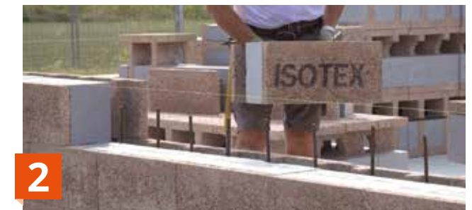
2 Los tendeles sucesivos se ponen en seco
