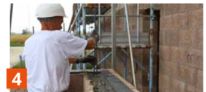
4 Inserción de refuerzos verticales con el hormigón fresco.
