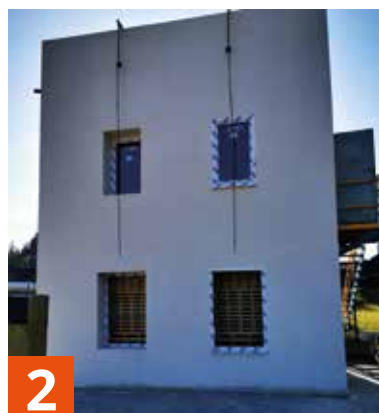
2 El muro de Isotex tenía 2 huecos en planta baja y primer piso más un velo sin huecos en la parte superior.
