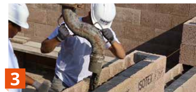
3 Relleno con hormigón los bloques (cada 6 tendeles)
