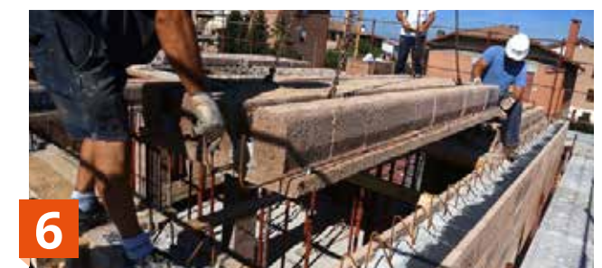
6 Instalación de los paneles de forjado calculados y hechos a medida
