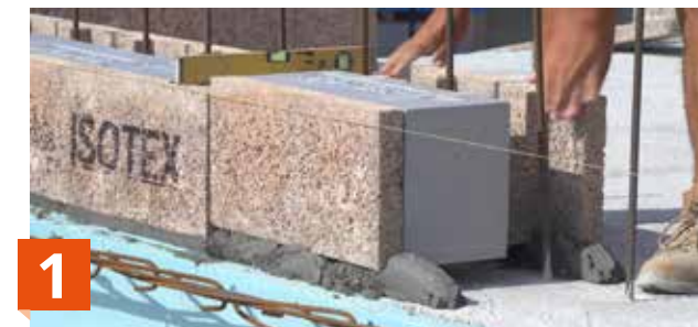
1 Colocación de la primera hilada sobre mortero, con nivel.
