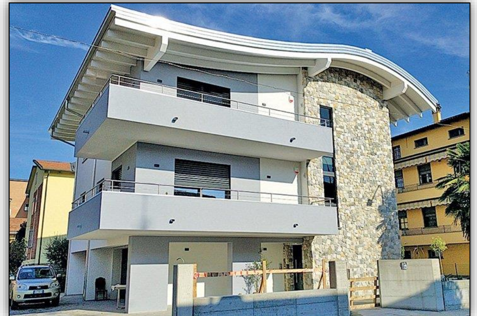
Rivestimento in pietra naturale Casa singola a Modena (MO)
