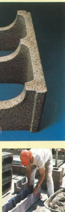
Anlegen der 1. Schicht Innen- und Außenwände.
