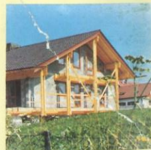
Einfamilienhaus, gebaut mit ISOTEX-Holzspandämmsteinen D III 30.
