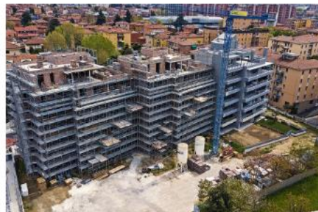
Palazzine 7 piani Esempio edificio Classe SB
