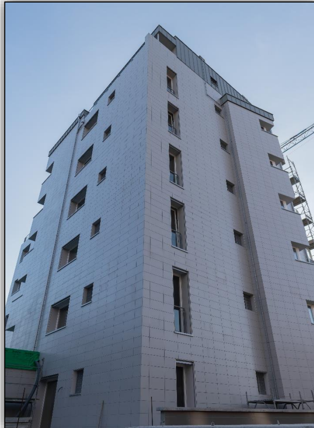
Rivestimento in gres porcellanato Palazzine 7 piani a Bologna
