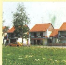
Reihenhäuser, gebaut mit Holzbeton- Holzspandämmsteinen D II 30.
