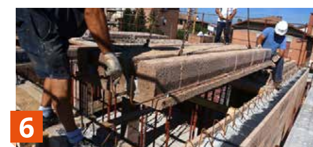
6 Posa dei pannelli solaio calcolati e realizzati su misura
