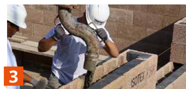
3 Riempimento del calcestruzzo nei blocchi (ogni 6 corsi)
