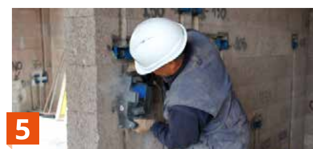
5 Realizzazione di tracce con la scanalatrice
