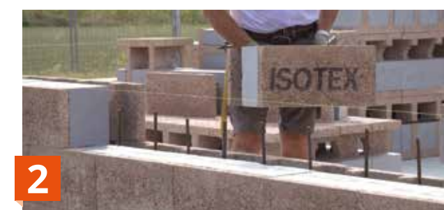
2 I corsi successivi si posano a secco
