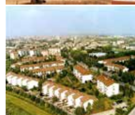
Quartiere Residenziale Fidenza (PR)
