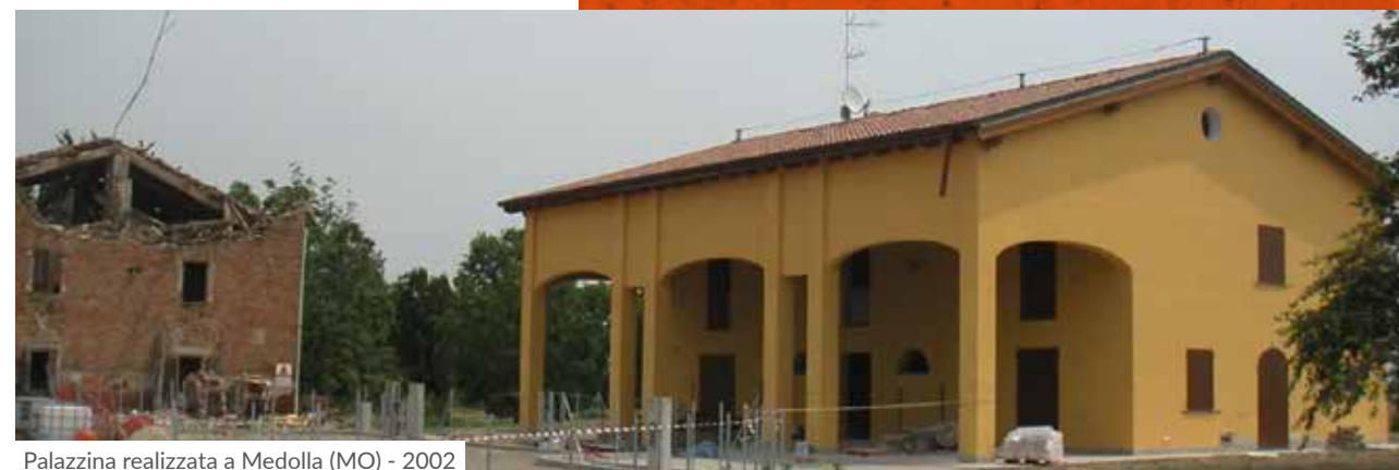
Palazzina realizzata a Medolla (MO) - 2002
