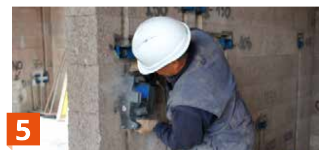
5 Realizzazione di tracce con la scanalatrice
