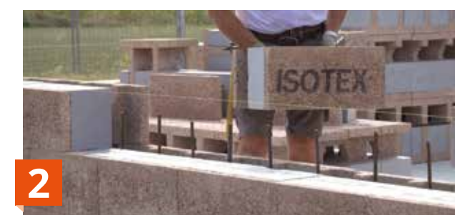
2 I corsi successivi si posano a secco
