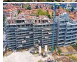
Edifici 7 piani a Bologna
