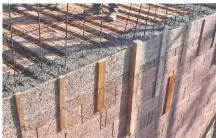
Coibentazione cordolo solaio
