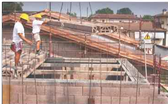
I puntelli di sostegno dei pannelli possono arrivare fino a 1,80 m.
