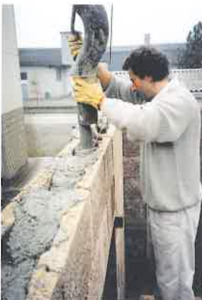
Ogni 6 corsi in altezza viene fatto il getto in C.L.S., che deve essere vibrato.
