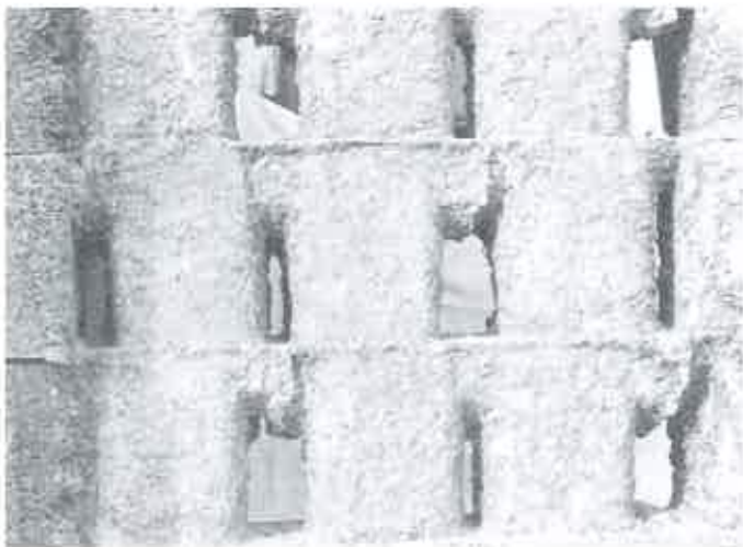
La disposizione all'interno dei blocchi del c.i.s.
