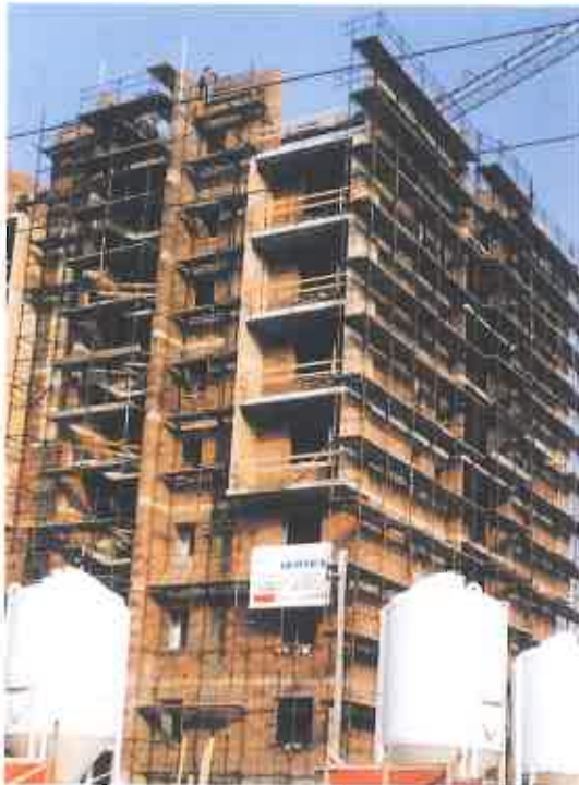
Edificio a 8 piani realizzato interamente sfruttando la struttura a pareti portanti in c.l.s. ottenuta all'interno dei casseri.
