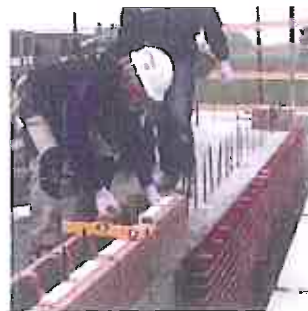
Il primo corso viene posato a malta per metterlo bene a livello.
