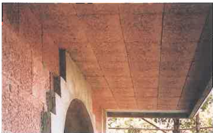
Il solaio "Isotex" consente di realizzare strutture a sbalzo, tipo cornicioni e balconi, con conseguente eliminazione del ponte termico
